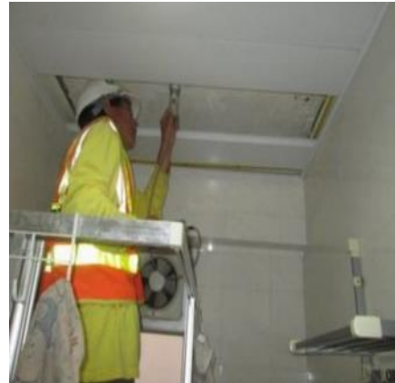
圖三及圖四：聯辦處聘用的顧問公司在涉事單位使用色水進行地台蓄水測試以及使用微波斷層掃描查找滲水源頭
